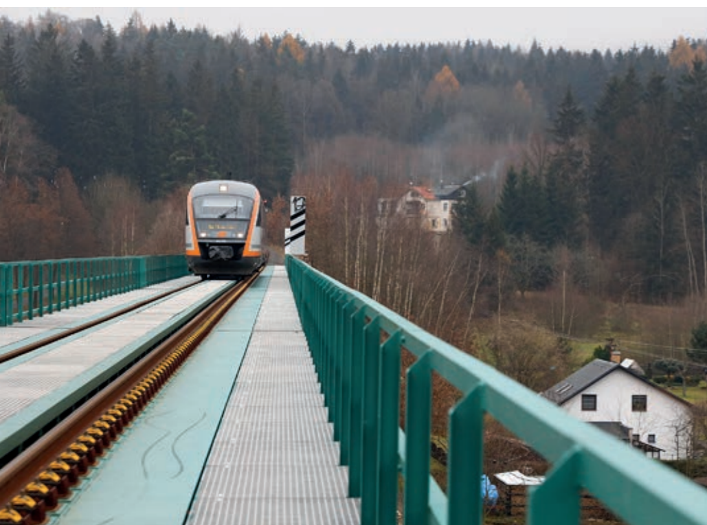
Das 1903 zusammen mit dem Streckenabschnitt Nixdorf – Sebnitz errichtete und 2020–21 komplett erneuerte Wölmsdorfer Viadukt überspannt auf 225 Metern Länge das Sebnitztal auf einer Höhe von maximal 34 Metern.
